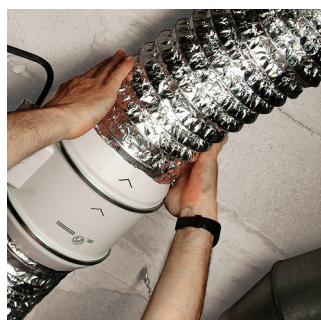
Montaż kanałów wentylacyjnych
