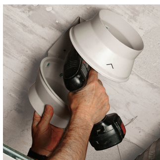
Przymocowanie wspornika
